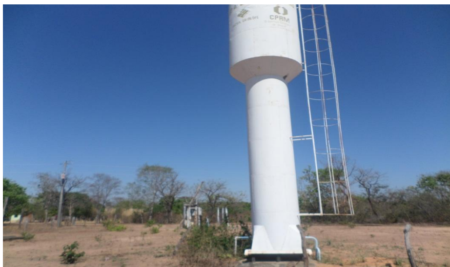
Figura 57-Caixa d'água e Poço Subterrâneo ativo P.A Santo Antônio dos Gerais
