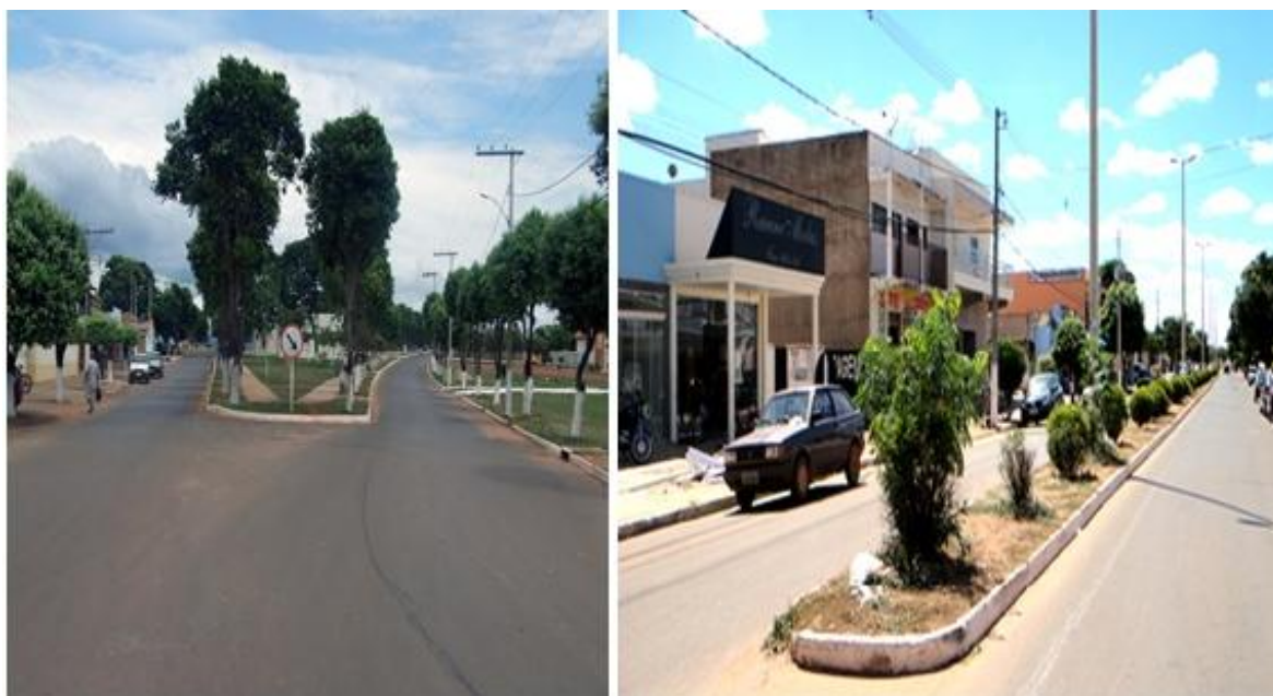
Figura 65 Pavimentação asfáltica do município
