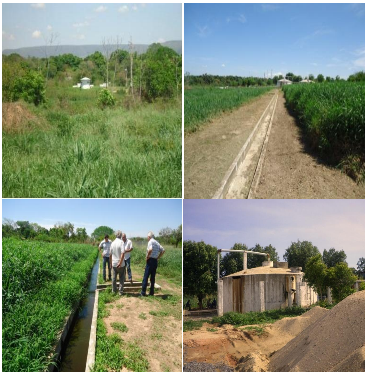
Figura 77 - Imagens ETE – Estação de Tratamento de Esgoto.
