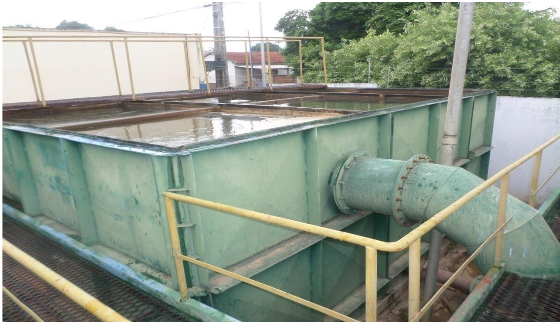
Figura 22- Decantador
