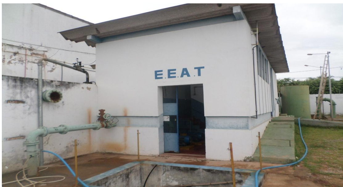
Figura 24- Estação Elevatória de Água Tratada
