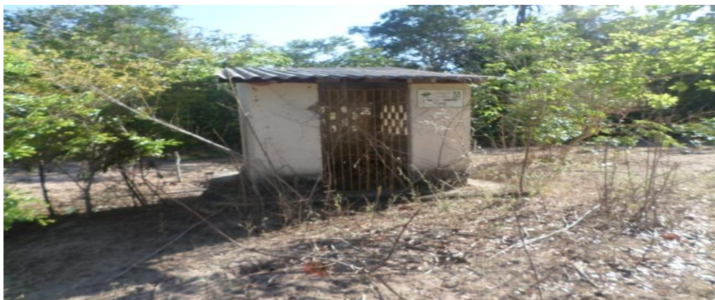
Figura 49- Poço Artesiano inativo P.A Mimo
