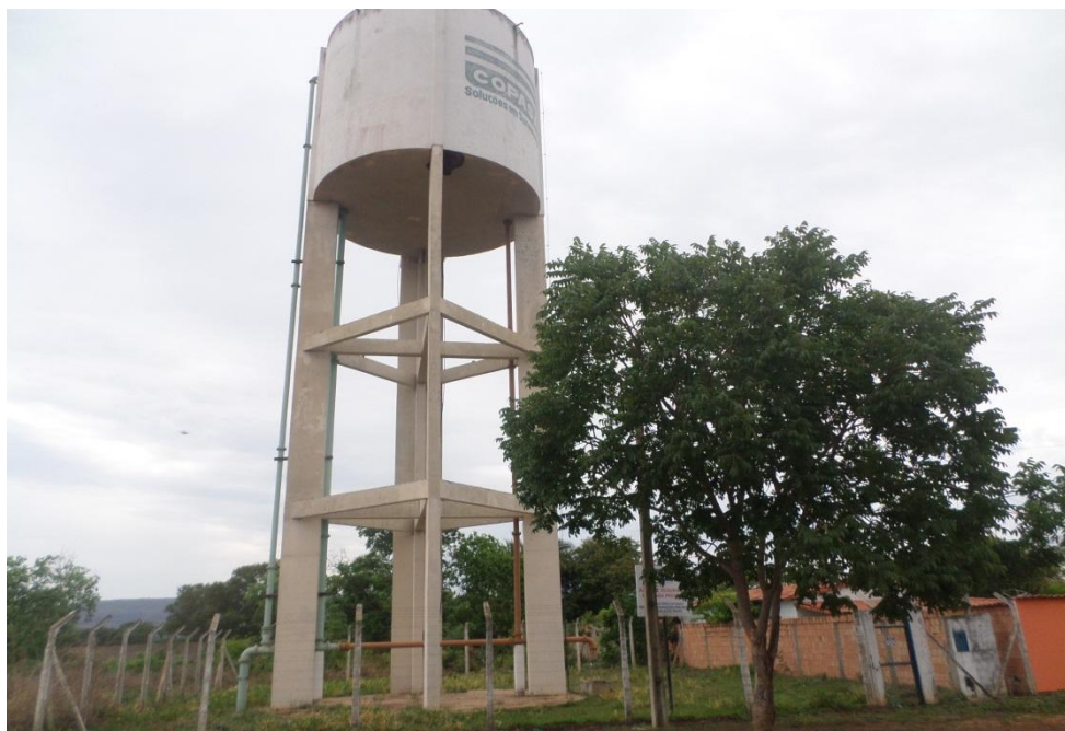
Figura 25- Um dos reservatórios da COPASA
