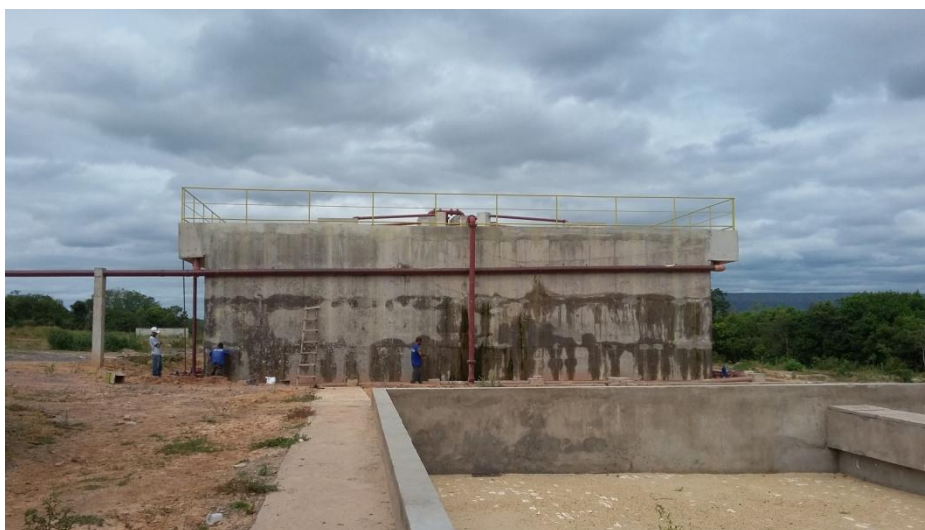
Figura 61 -Placa, e obras de ampliação da ETE
