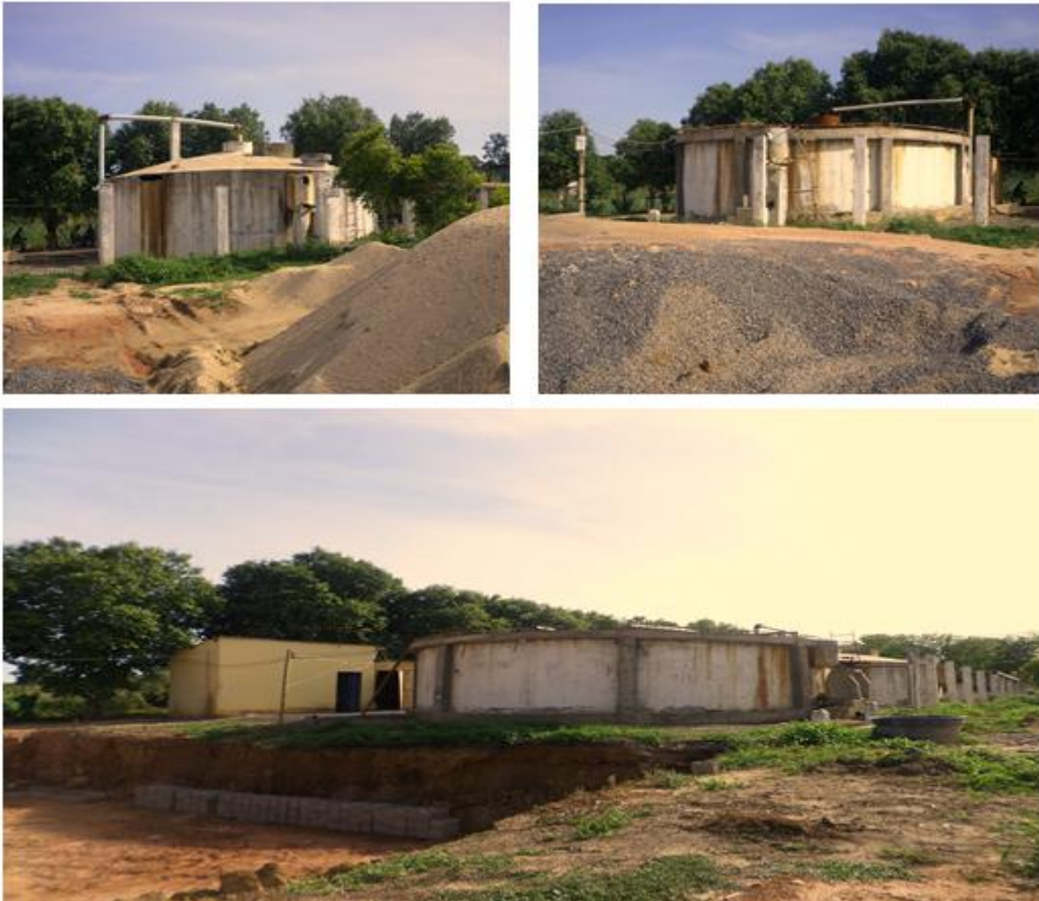
Figura 59 Antigos reatores da Estação de Tratamento de Esgoto
