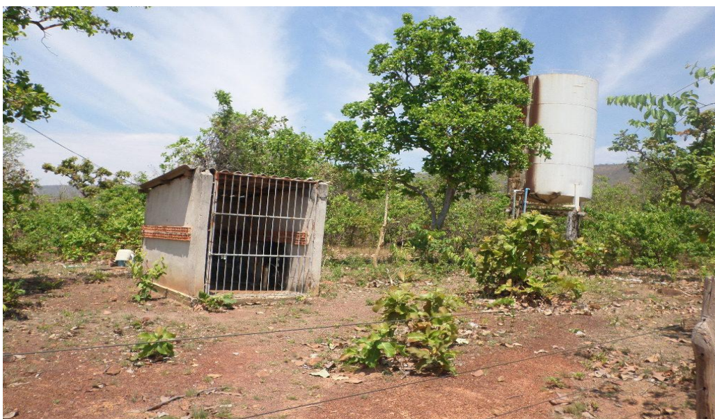
Figura 52- poço e Caixa d'água em pleno funcionamento P.A Santa Terezinha
