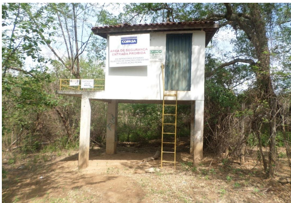
Figura 20- local da captação de água
