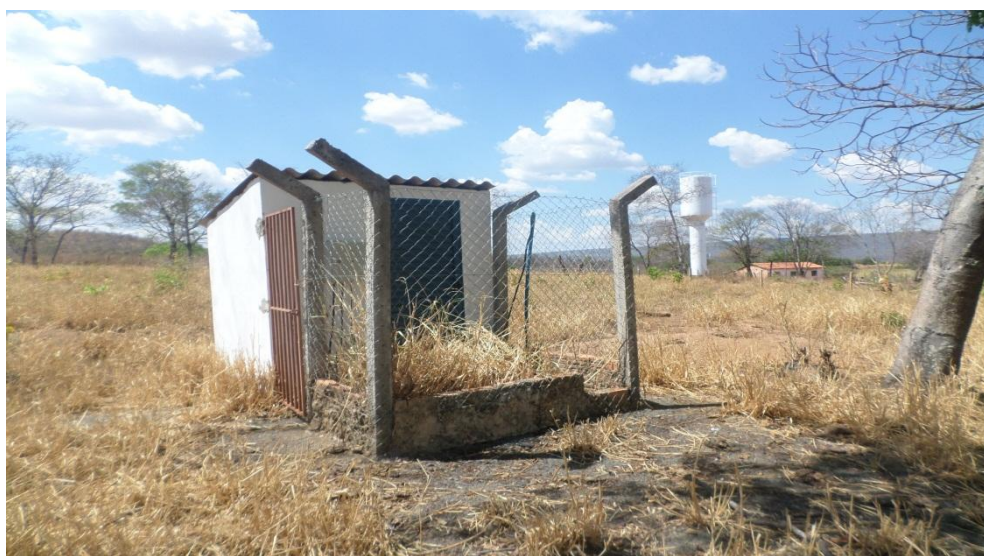
Figura 27- Poço Subterrâneo 01 P.A Carlos Lamarca
