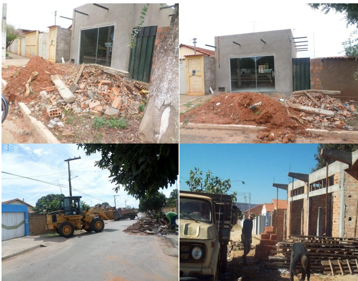
Figura 71 - Imagens de construção civil e demolição.
