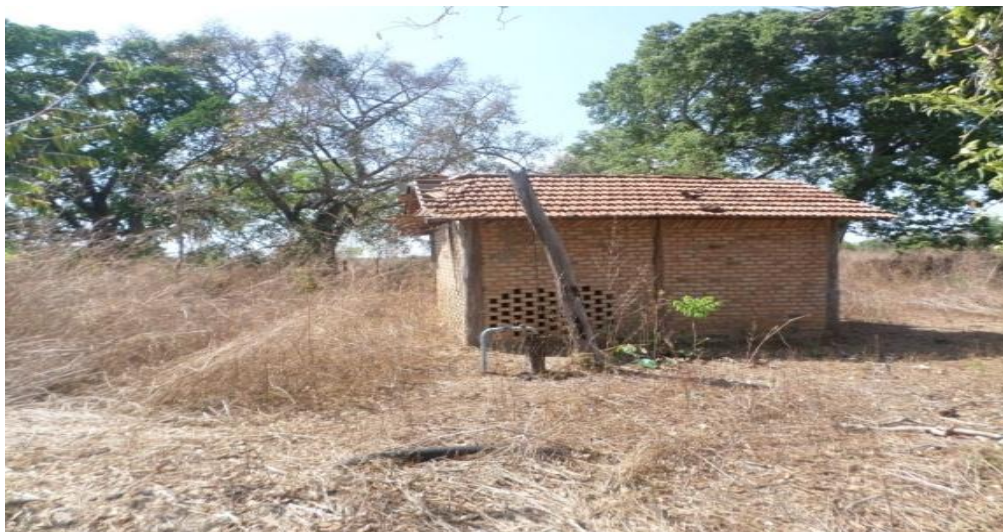
Figura 37-Poço Subterrâneo Agrovila Cabral
