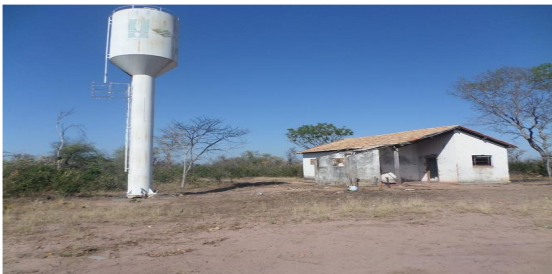
Figura 50- Caixa D'água e poço desabilitado
