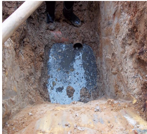
Figura 62 Problemas nas redes de esgoto, com entupimentos, extravasamentos.
