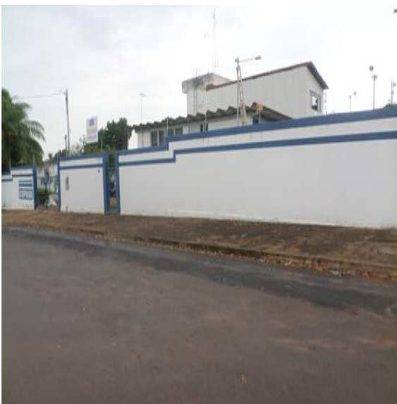
Figura 17- Estação de tratamento de água (ETA)
