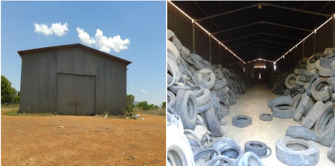
Figura 78 - Galpão de armazenamento dos pneus
